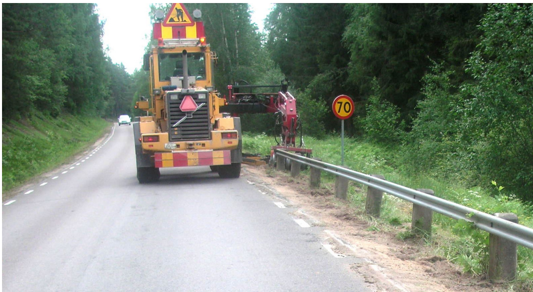
Bild 06 Kantskärning med kanthyvel under räcke med betongståndare.
