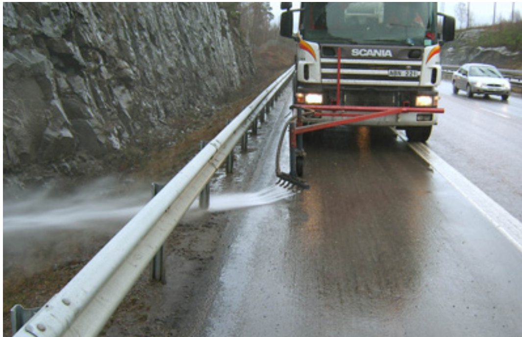
Bild 01 Kantskäring under räcke med vatten.
