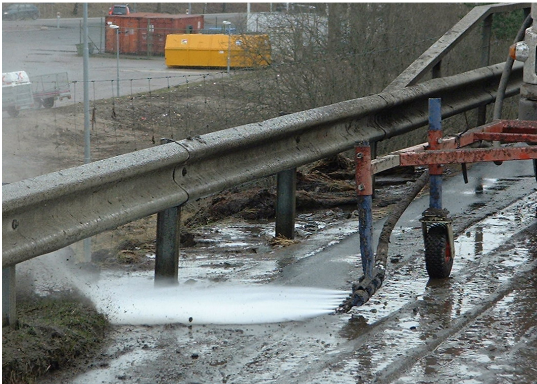
Bild 03 "Jumbo spolbil" med förlängningsarm och spolmunstycke utför kantskärning under räcke på tungspolad sträcka.
