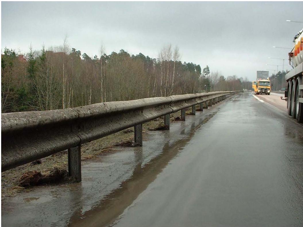
Bild 02 Resultat efter kantskärning med vatten.
