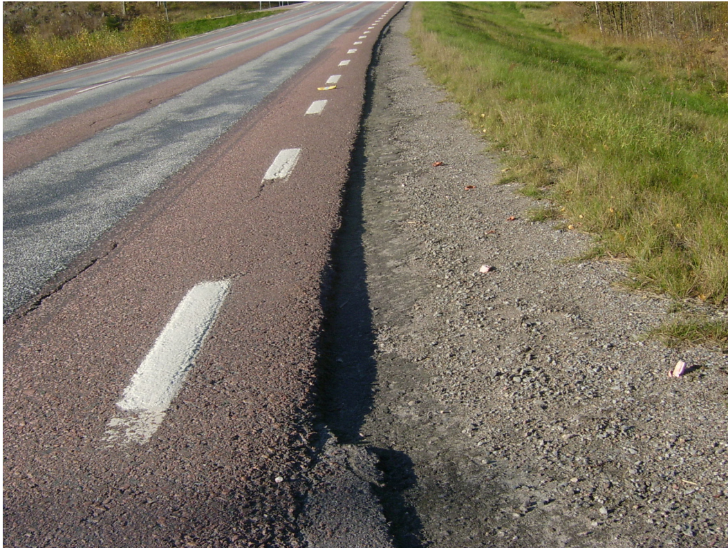
Bild 12 För låg stödkant med kompletteringsbehov.
