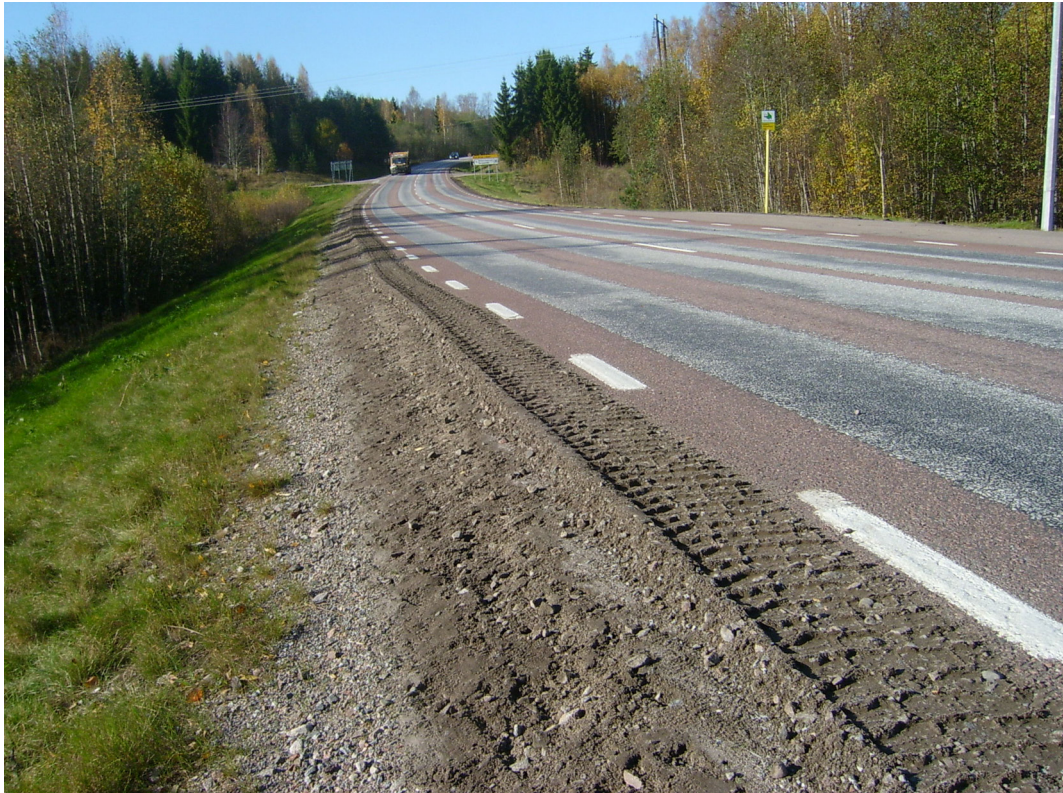
Bild 13 Resultat efter komplettering med stödkantsindragaren.
