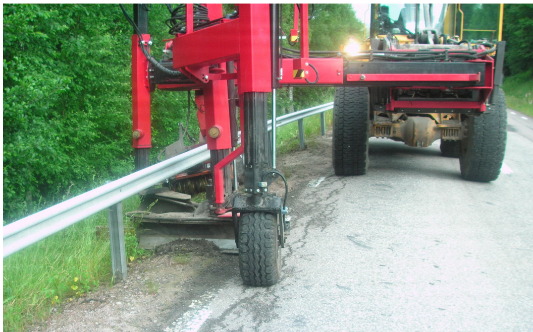
Bild 07 Kantskärning med kanthyvel under räcke med sigmaståndare.
