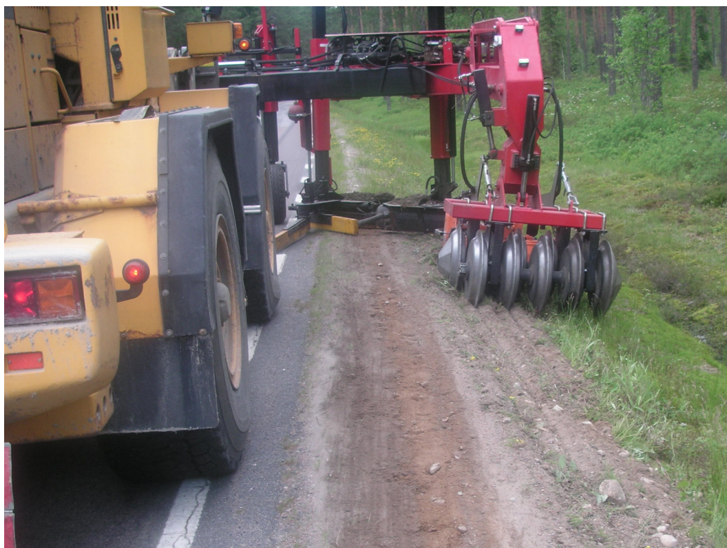
Bild 05 Kantskärning med kanthyvel. "Packaren" skär sönder och jämnar ut materialet.
